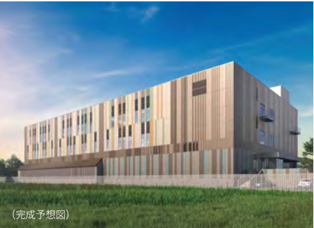
(完成予想図) 北海道石狩市における再エネ100％で運営するデータセンター
