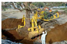
TPM機械による移植作業
