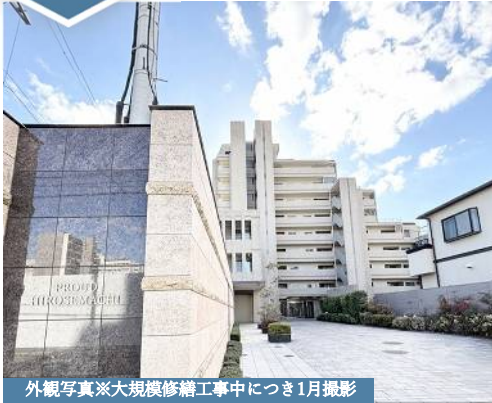
外観写真※大規模修繕工事中につき1月撮影
